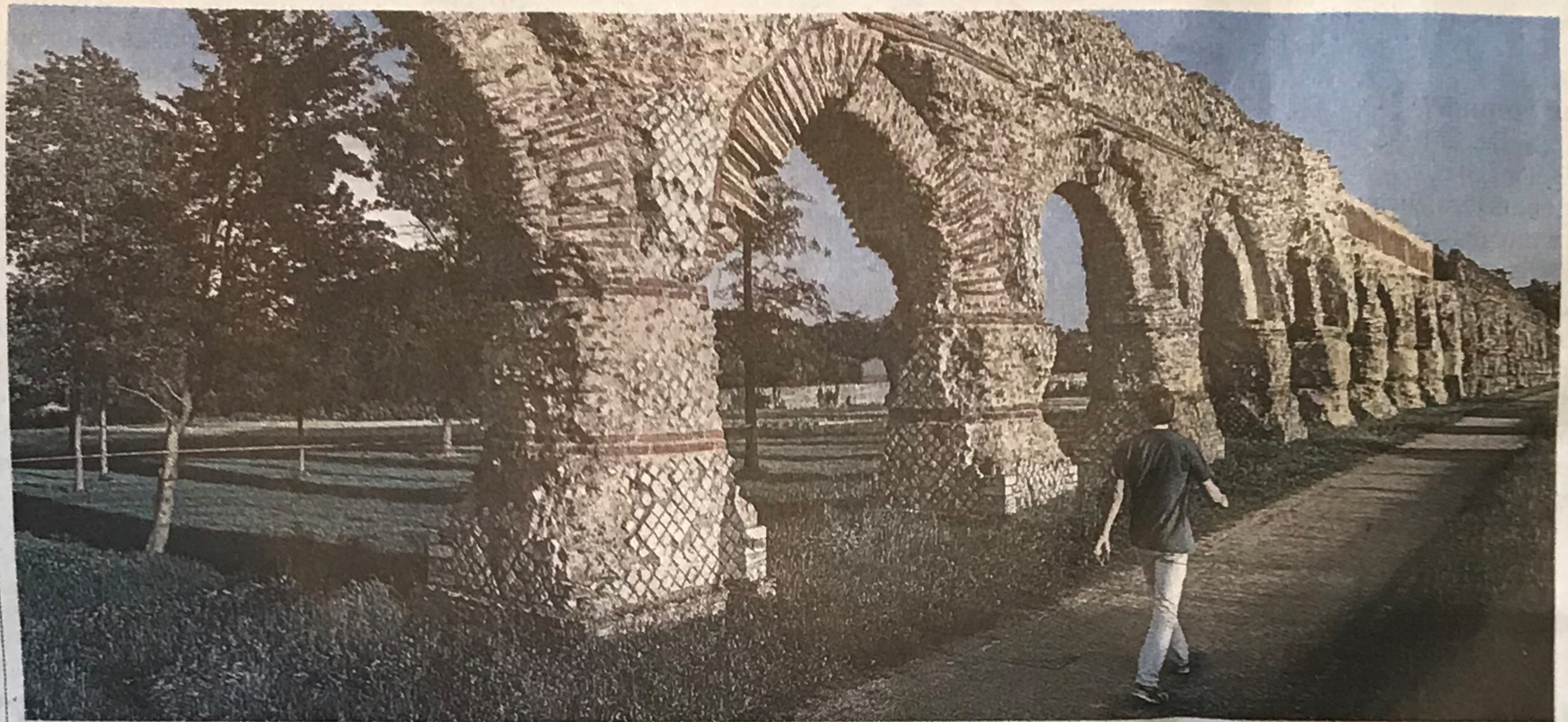
RESTAURATION. L'aqueduc du Gier, à Chanopost, a déjà retenu l'attention de la mission Bern. Il fait partie des 22 sites retenus en Auvergne-Rhône-Alpes pour bénéficier de la cagnotte du tirage du Loto du Patrimoine. Photo Philippe Desmazes/AFP
